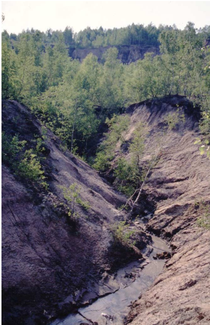
Abb. 6: Erosionsrinnen an der Halde Trages - Beispiel für Arten- und Prozessschutz
